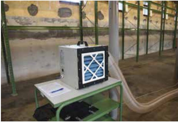
Abb. 5: Das UHG saugt den aufgewirbelten, potenziell belasteten Staub ein und stösst die gefilterte Luft wieder aus.
